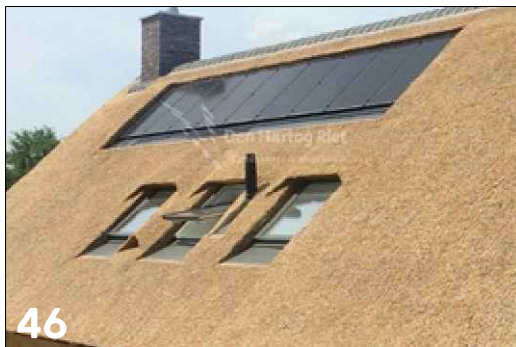
Zonnepanelen geïntegreerd in rieten dak
