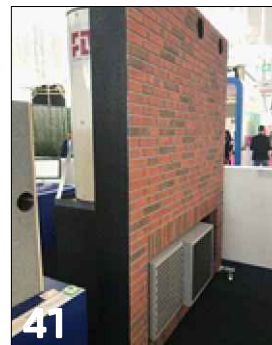
Buitenunit inpandig in gevel verwerkt
