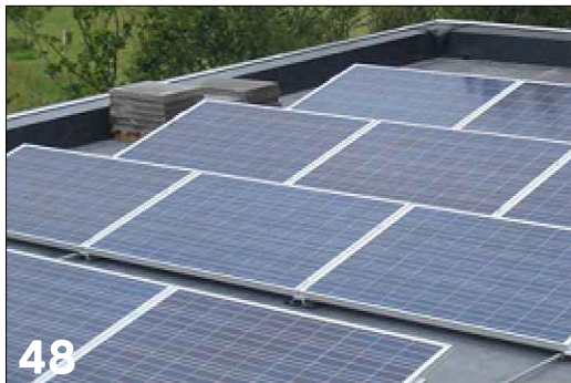
Zonnepanelen op plan dak met hogere dakrand/dakopstand
