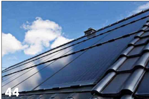
In het dak geïntegreerde zonnepanelen
