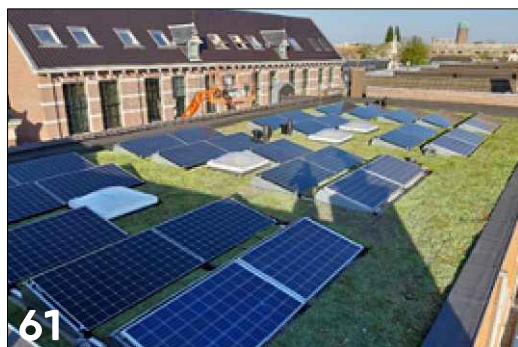
Extensief groen dak in combinatie met zonnepanelen
